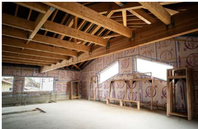
Travaux rétro énergétique © Ville de Tours
